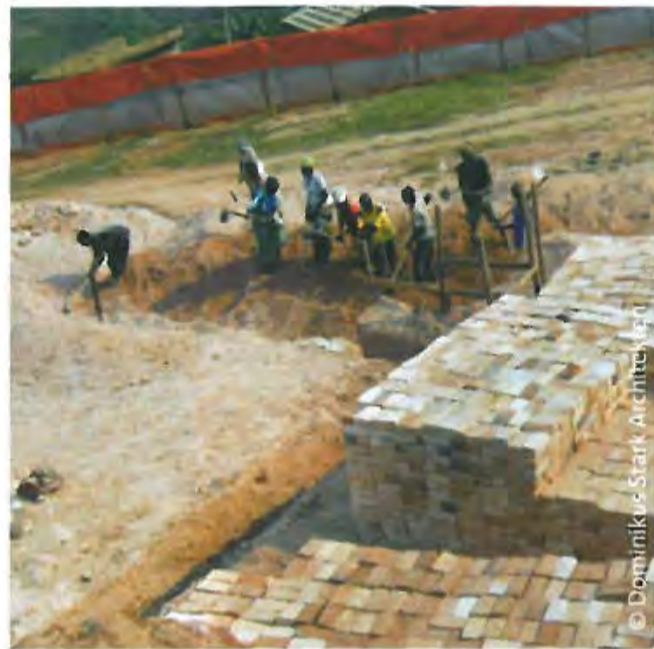
▲ Lokaler Baustoff: Handgeformt und vor Ort gebrannt.
